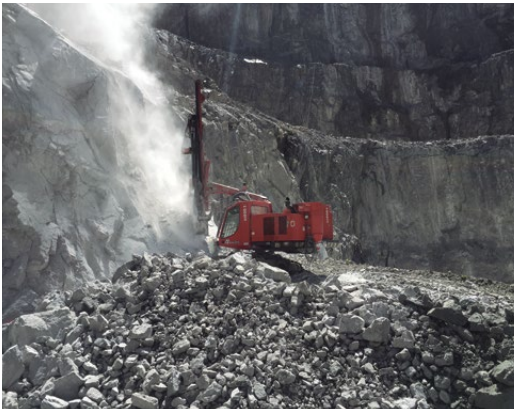
Carro realizando la perforación.
