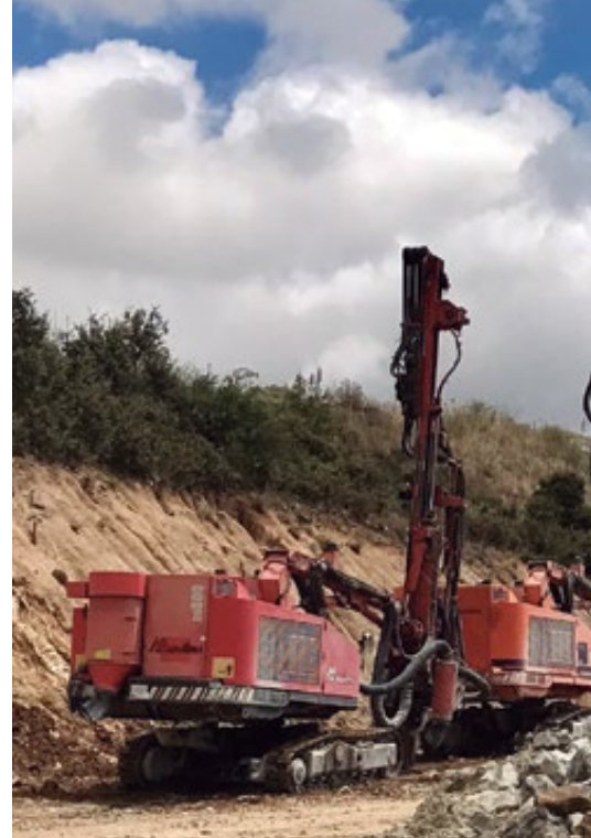
Batería de carros de perforación retirados del frente durante la voladura.
