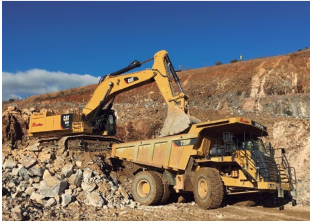
Movimiento de material volado en el frente.
